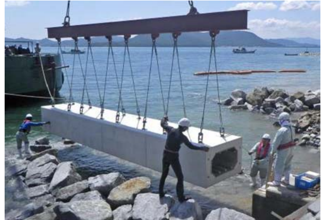
製品名：CG ボックスカルバート（耐塩害・高耐久性ボックスカルバート）
