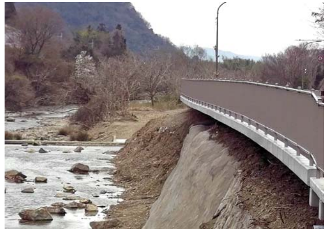
製品名：張出歩道【SSステージ】(国道29号松山地区歩道整備工事(兵庫県姫路市))
