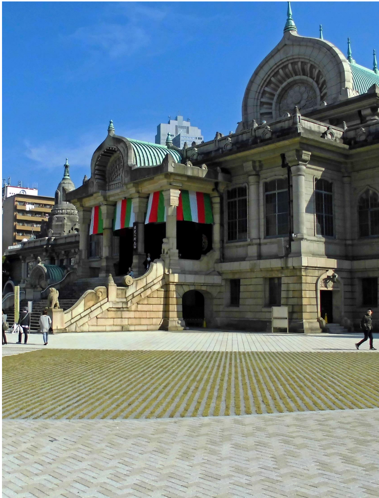
築地本願寺修景整備
