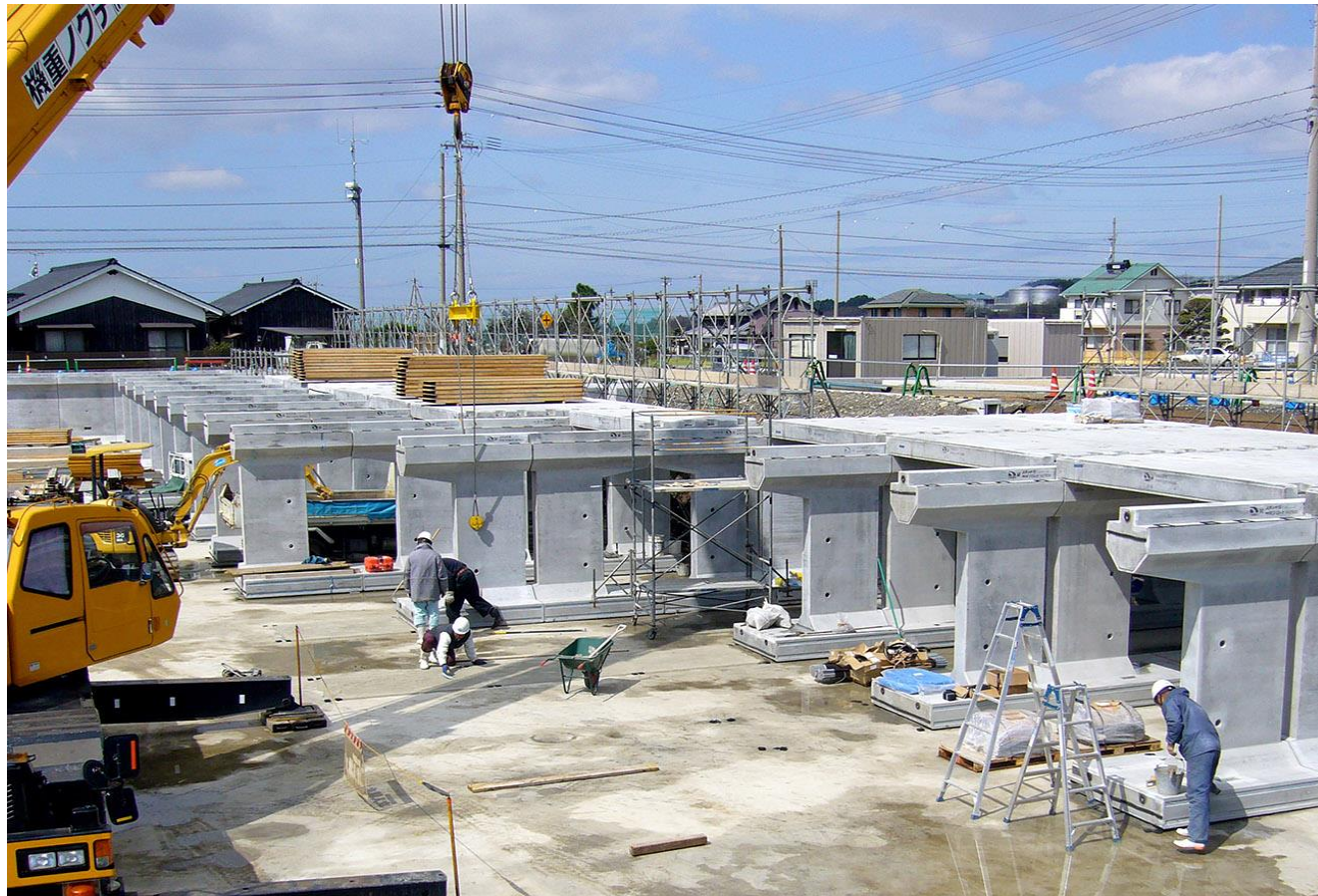
志津川地区2号調整池整備工事
