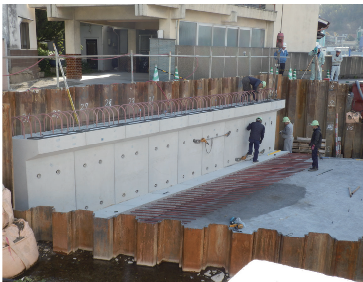
側壁ブロックの据付
