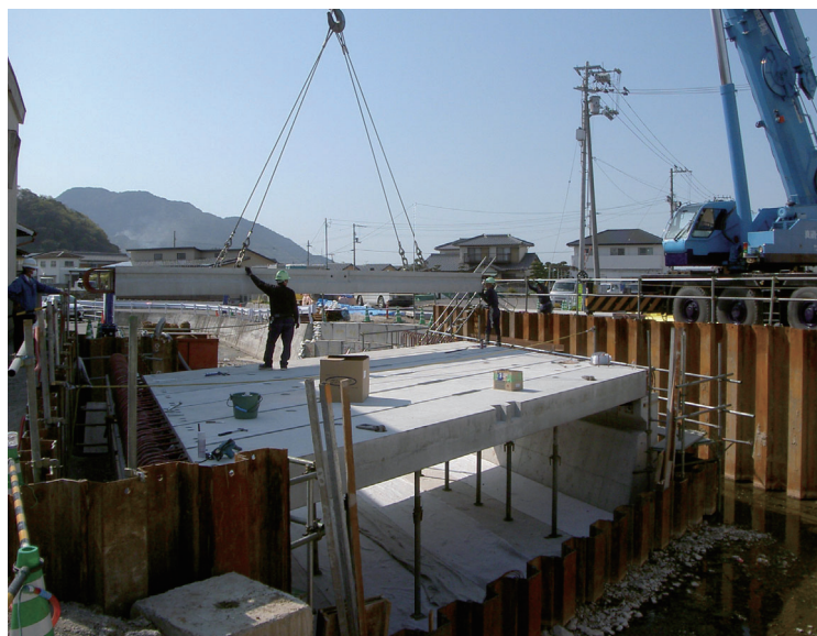
頂版スラブの据付
