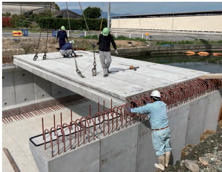
頂版スラブの据付
