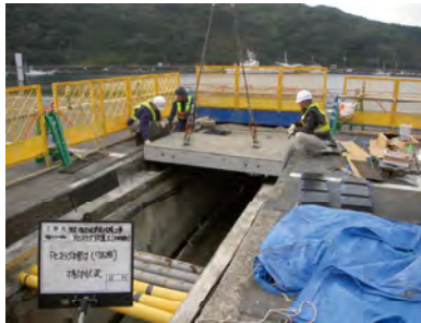
④-1 施工（スラブ据付）
