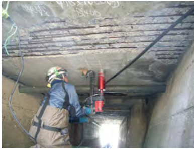
①-2 調査・点検（コア抜き）
