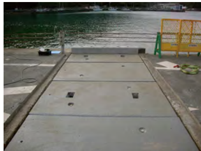
④-2 施工完了
