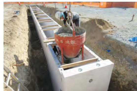
大型U字側溝形状でインバート打設もスムーズ
