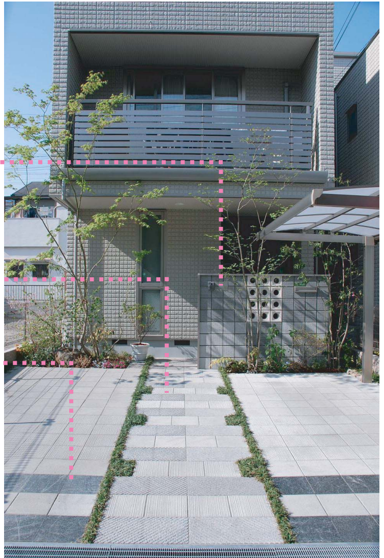
K邸外構工事
