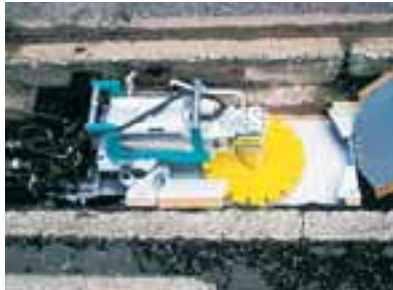
W 2 Rカッターによる切断
