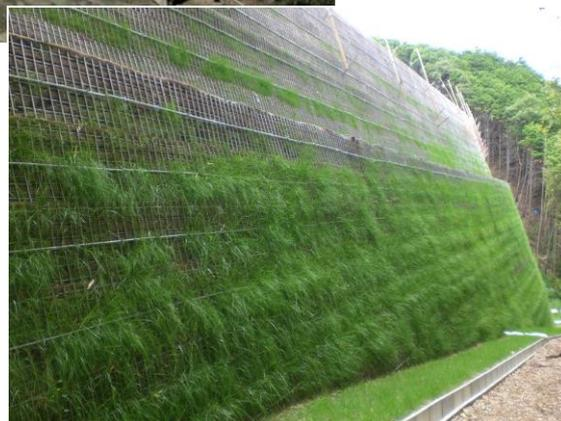
・壁面材には枠型と網型があり、壁面の緑化も図れます。
