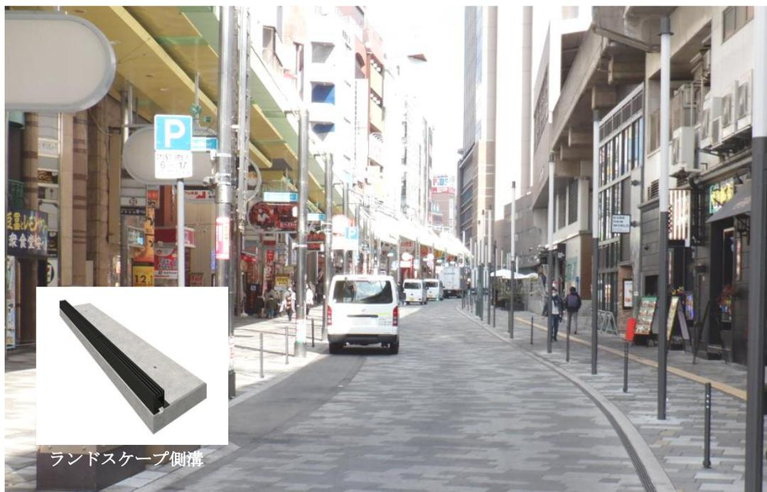
ランドスケープ側溝は、グレーチングを側溝端部に設置した片寄側溝構造により、官民境界ギリギリに側溝を配置することができ、地上にはスマートな鋳物グレーチングのみが露出する、意匠性にも優れた景観型側溝です。また、グレーチングはノンスリップ仕様となっており、歩行者の安全も確保しております。
