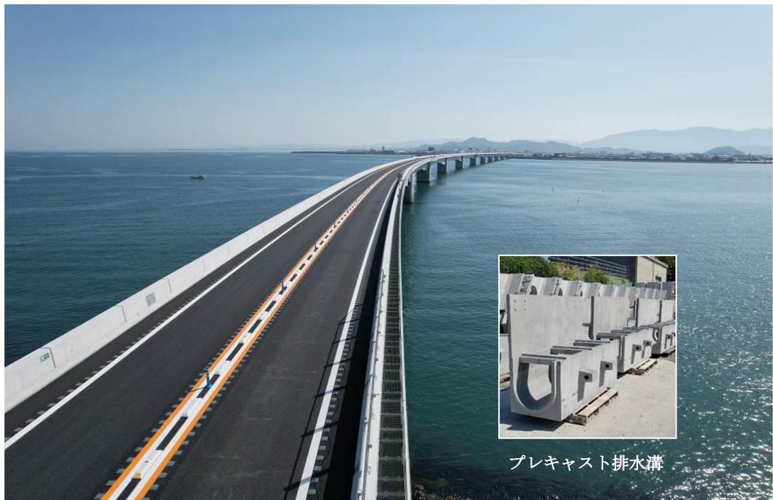
弊社は排水溝の製造を担当。床版一体型排水溝とすることで、景観性の確保はもとより、塩害対策が不要な材料の使用により高耐久性並びに水密性を確保し、排水を一切吉野川に落とさない環境への配慮も実現するなど、吉野川サンライズ大橋建設に係る課題解決の一端を担いました。
