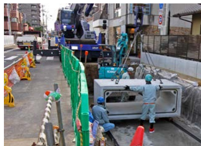
ローラーキャリア工法でレッカーによる道路占有を防ぎ片側通行を可能としております。
