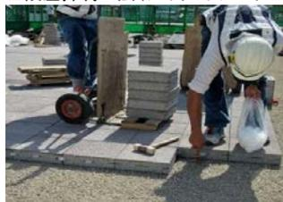
舗装ブロックを特殊ジョイントパーツで連結することにより荷重分散効果を高め、施工時や経年変化による段差を抑制します。
