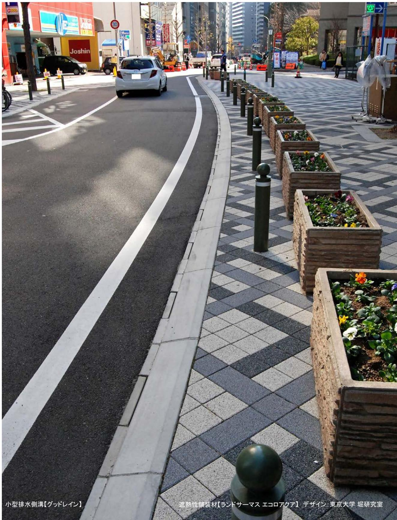
小型排水側溝【グッドライン】
