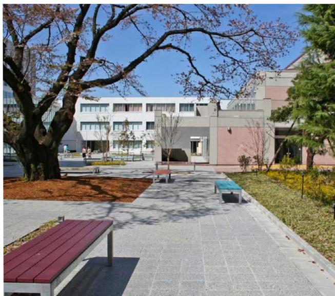
“SAZARE 細石 エコロアクア”は国土交通省新技術情報提供システムに登録されており、日野キャンパスは天然骨材を美しく洗い出した【ファインウォッシュ加工】と美しく磨き上げた【研磨加工】の2種類の透水タイプをいくつものグリッドとカラフルなベンチで美しくデザインされています。両加工とも天然骨材を表層部に露出させていますので高級感にあふれ、汚れにくく、月日を経るほどにエイジングで味わいが増してゆきます。
