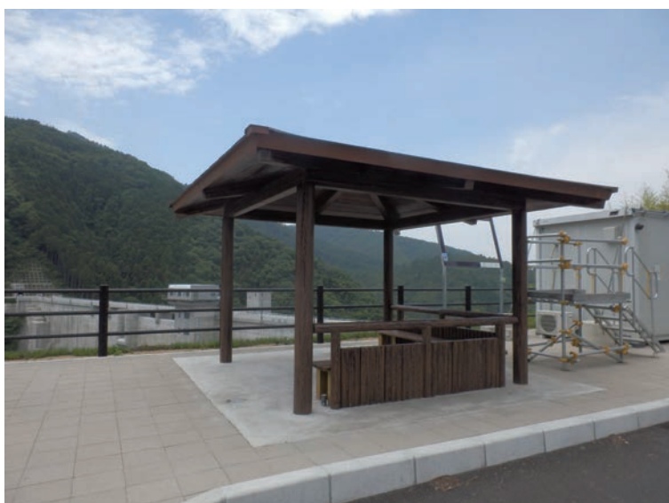
擬木パーゴラ（全景）
