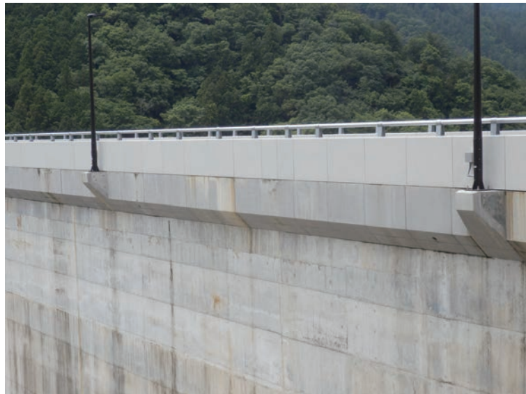
地覆（埋設型枠）+ 高欄（外側）
