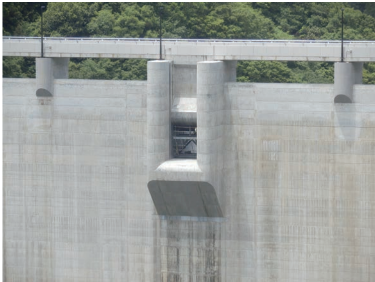
常用洪水吐（埋設型枠）、非常用洪水吐ピア（埋設型枠）
