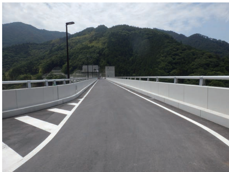
高欄（管理道路）
