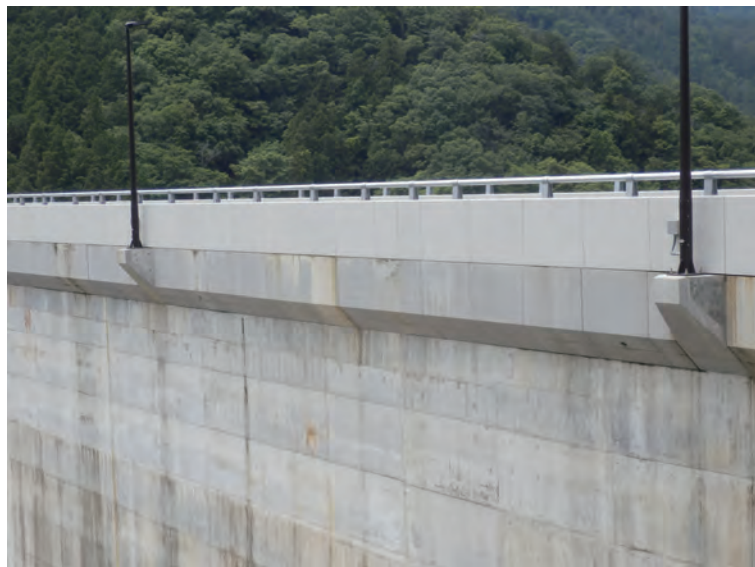
地覆（埋設型枠）+ 高欄（外側）
