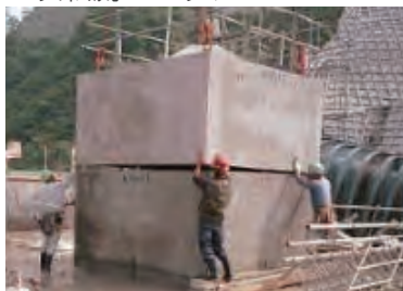
エレベーターシャフト
