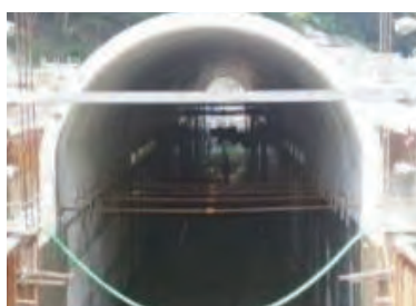
堤内仮排水路
