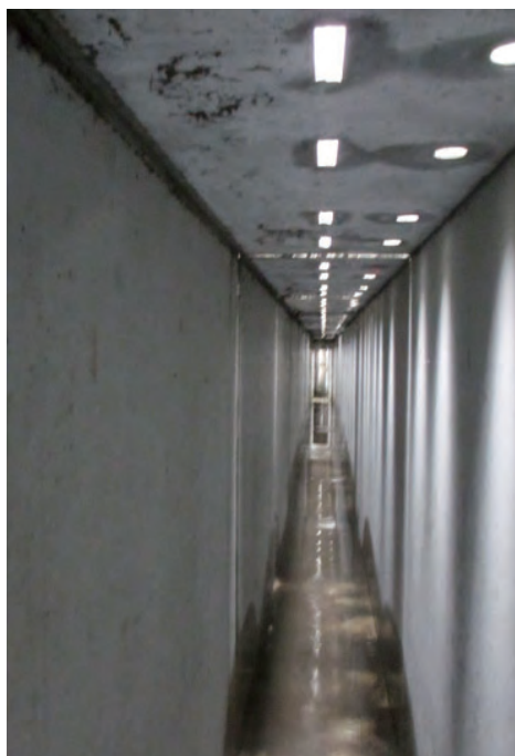
貯留側溝内部
